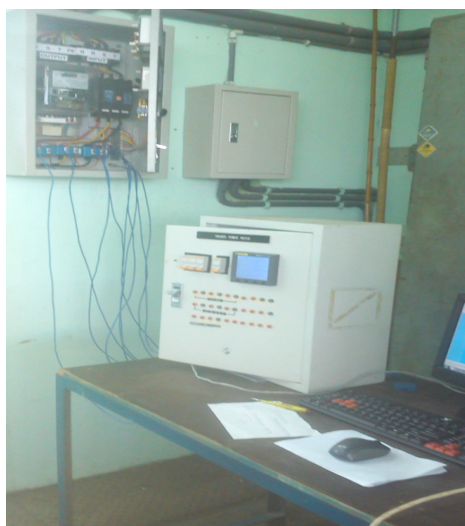
Gambar 3. Konfigurasi Power meter dengan Panel Penerangan
